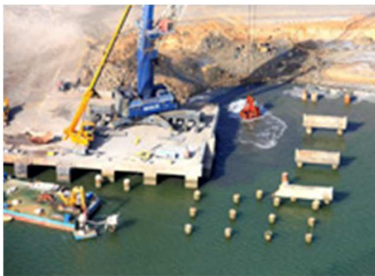
Construcción de la ampliación del muelle Ingeniero Juan Gonzalo en el puerto exterior de Huelva
